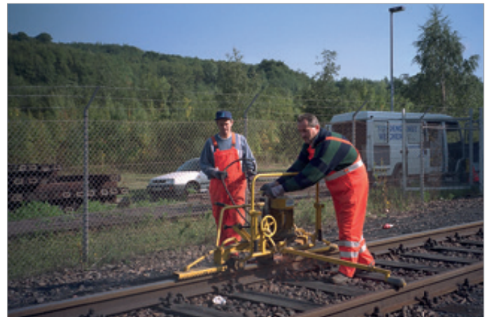
Schleif- und schweißtechnische Schienenbearbeitung sind die Basis der korrekiven und präventiven Weicheninstandhaltung.
