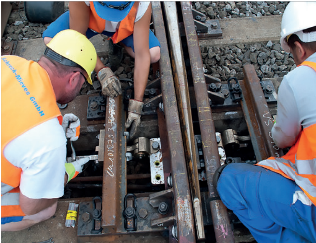
Einbau und Instandhaltung von Verschluss- und Stelltechnik gehören zu den Aufgaben des Weichenschlossers
